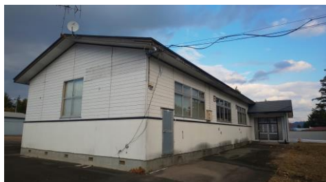
倉庫A外観
