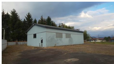
倉庫B外観
